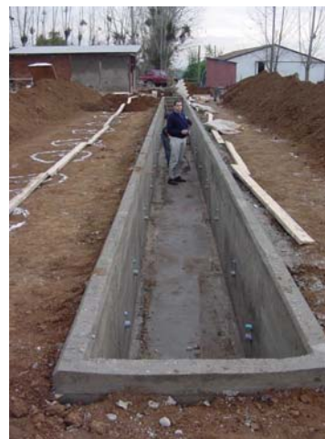
Foto 2. Vista de los avances en la construcción del lisímetro.
