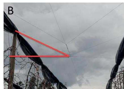
**Foto 3.** Diseño de estructura del tipo plano (A) y capilla (B), comúnmente utilizados en huertos de manzanos cubiertos con mallas.
